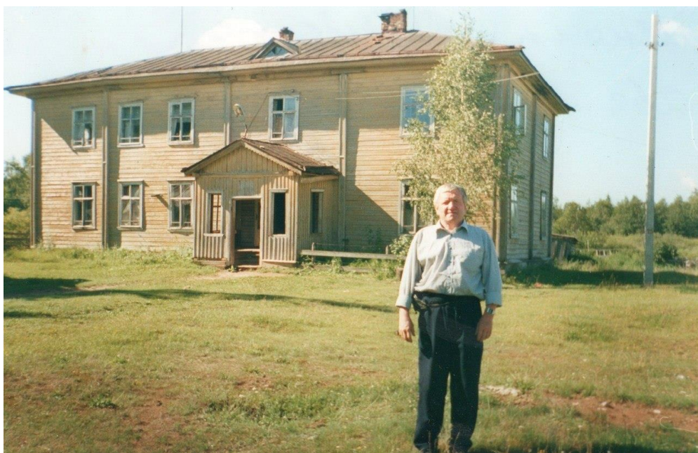
Фото 4. Здание Рубежской школы, 2014 г. Фото из Интернета
