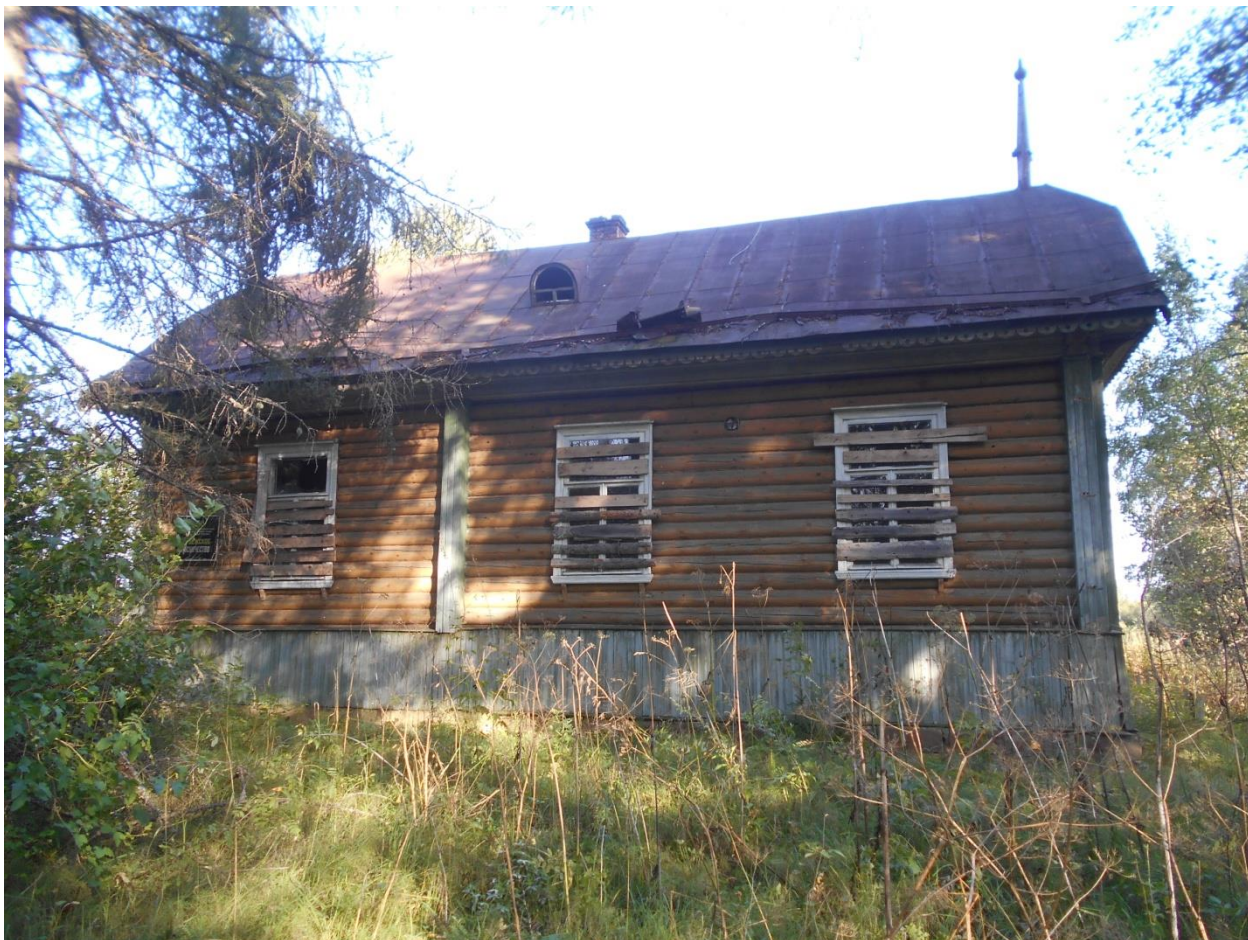
Фото 3. Здание бывшей конторы Рубежского лесопильного завода, сентябрь 2018 г.
